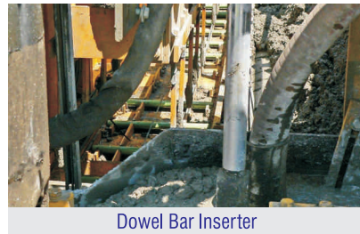
Dowel Bar Inserter
